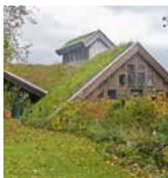
↑↑ Eine großflächige extensive Dachbegrünung in Gmunden.
